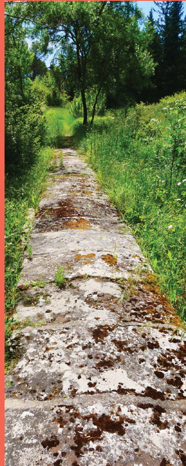
Passage de l'aqueduc - St Clément de Rivière
